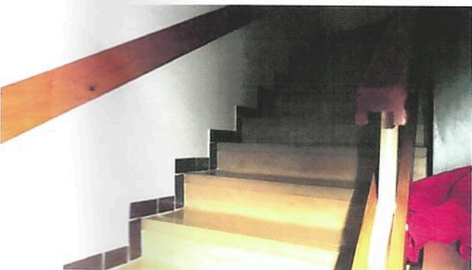
Schody na 2.NP
