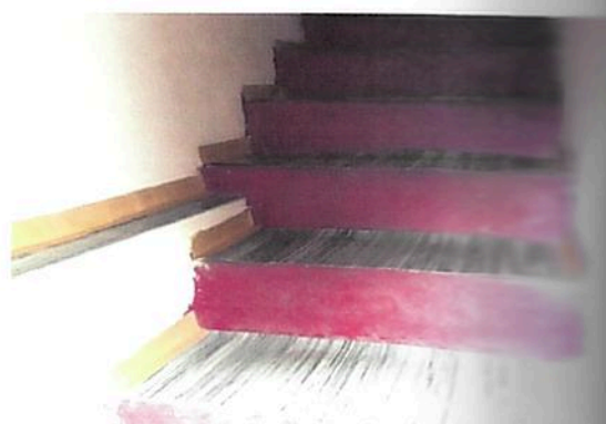
Schody do pivnice 1.PP
