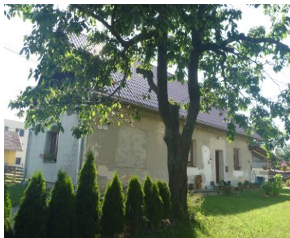
RD č. s. 133 - celkový pohľad V z p. č. 402
