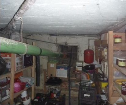
Miestnosť v I. PP - sklad - pohľad od schodov
