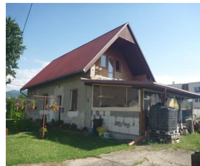
RD č. s. 133 - celkový pohľad S z p. č. 421
