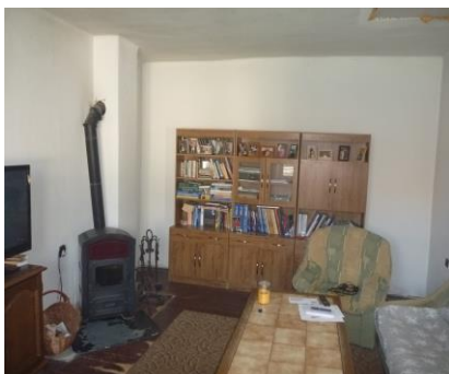
Izba prechodná s lokálnym vykurovaním liatinovou pecou na pevné palivá
