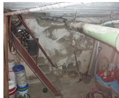
Miestnosť v I. PP - sklad, prístupný oceľovými schodmi cez otvor v strope
